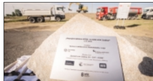
Výstavba obchvatu začala v srpnu 2022 | Zdroj: www.obchvatdasice.cz
