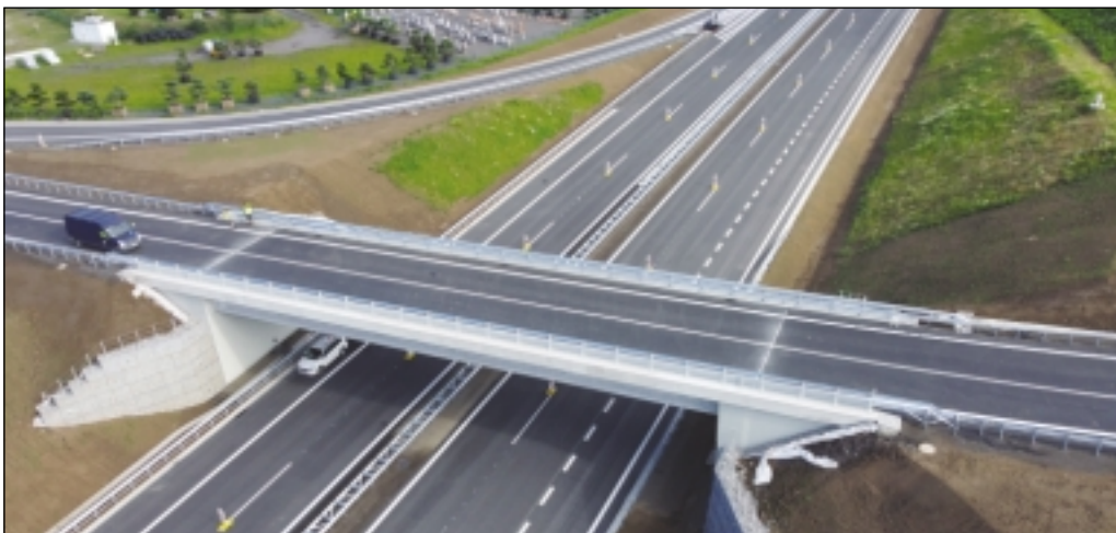
Projekt D4 klade velký důraz na ekologické aspekty projektu. Recykluje se téměř 100 % vyfrézovaného asfaltu a zemina z trasy dálnice byla využita například pro pokrytí náspů.
