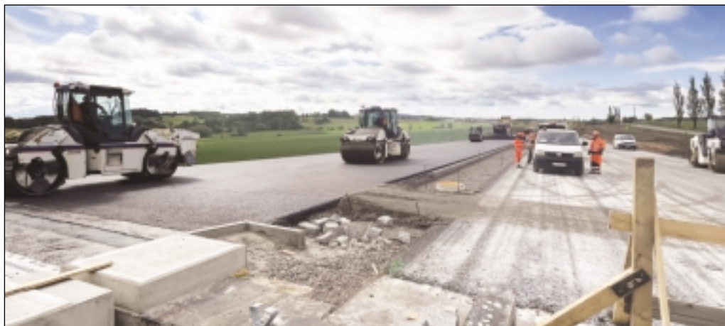
V nejvytíženějších měsících na stavbě v jeden moment pracovalo až 1600 stavbařů a přes 800 strojů. | Zdroj: Via Salis
